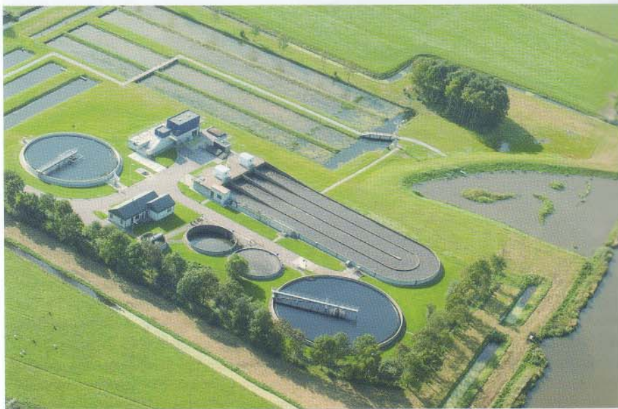
Aqualân Grou: zuiveringsmoeras bij de rioolwaterzuiveringsinstallatie: v.l.n.r. drie vijvers, verdeelslootje, vier rietsloten, paabiotoop voor snoek en boezemwater.
