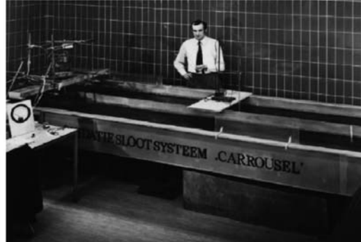
Figuur 7: Proefinstallatie carousel (DHV, 1975) (DHV, 2007)
