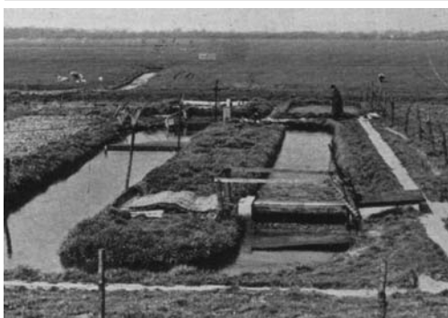
Figuur 5: De 'eenvoudige afvalwaterzuivering in Voorschoten, de eerste oxydatiesloot (Pasveer, 1958b)
