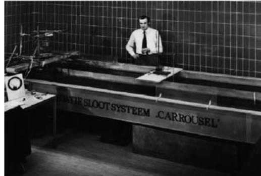
Figuur 7: Proefinstallatie carousel (DHV, 1975) (DHV, 2007)
